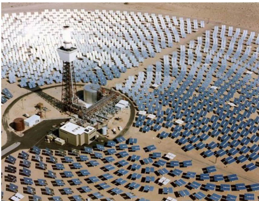
Рисунок 1 – Станції баштового типу
